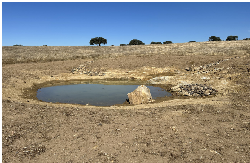
Neste “pond” recém-construído, são bem visíveis as linhas de erosão protegidas com pedras.
